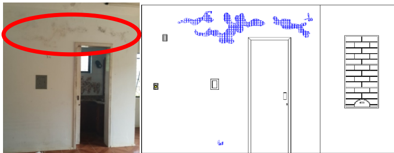
Figura 1 – Levantamento fotográfico e desenho gráfico da manifestação patológica
